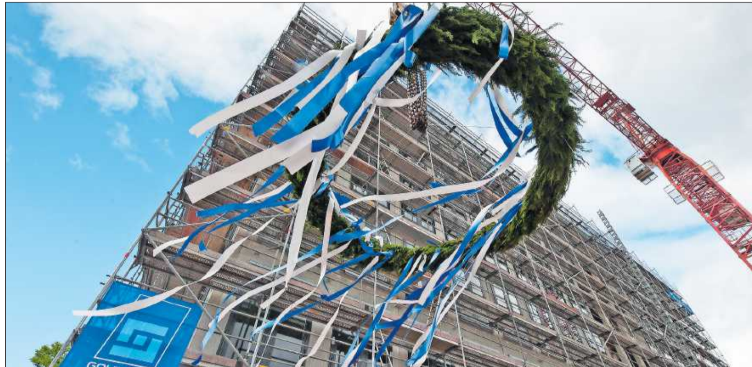
Der Richtstrauß wehte gestern am sechsstöckigen Bürogebäude, das die PRE derzeit errichtet.
