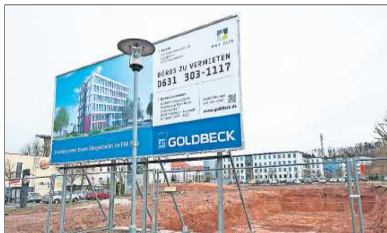
Ausgehoben: die Baustelle in der Brüsseler Straße.
