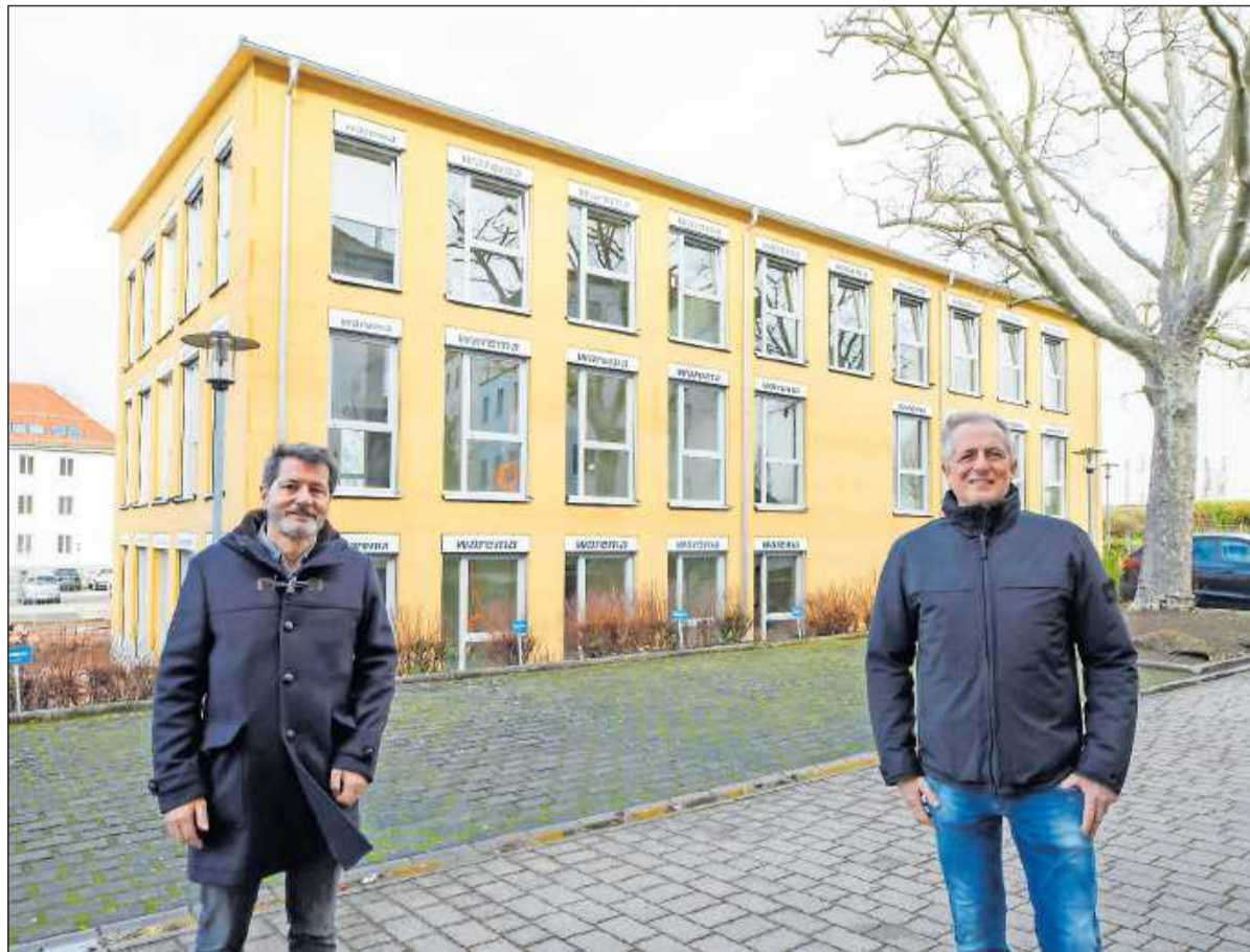
Hans Höhn (links) und Gunther Pfaff vor dem Holz-Neubau im PRE-Park. Nach einem eigens entwickelten Konzept fließen in das Gebäude viele verschiedene Aspekte nachhaltigen Bauens ein.
