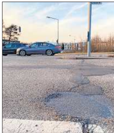
Sanierungsbedürftig: die Mainzer Straße/Ecke Donnersbergstraße.
