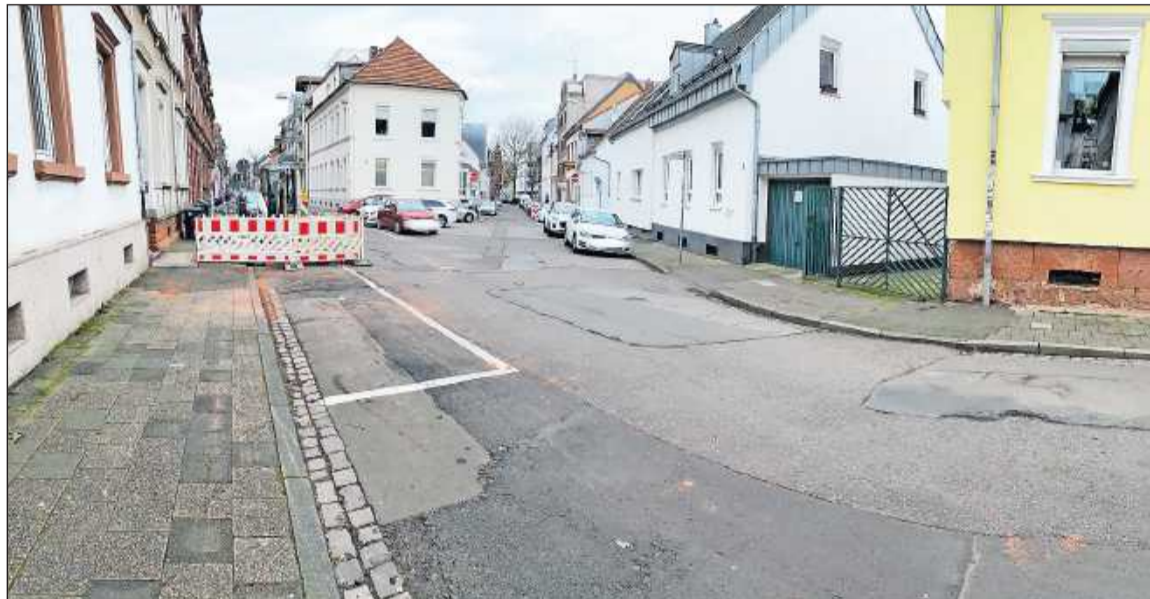
Beethovenstraße Ecke Brahmstraße: Wo jetzt in der Bildmitte noch Autos parken, soll eine kleine Grünfläche entstehen. Insgesamt werden dort beim Ausbau der Straßen 19 Bäume neu gepflanzt.
