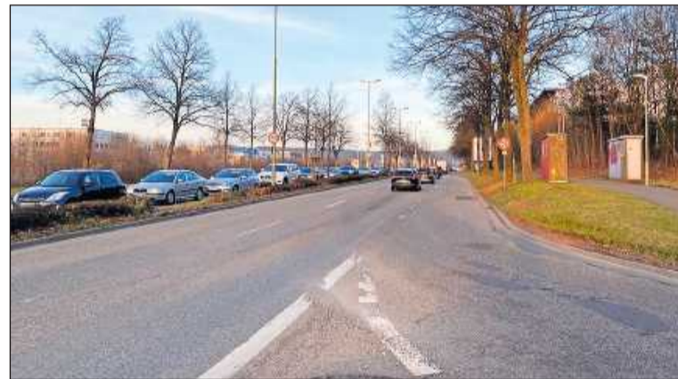
Wird in diesem Sommer neu asphaltiert: die Mainzer Straße von der Kreuzung aus bis zum Stadteingang – in beiden Richtungen.
