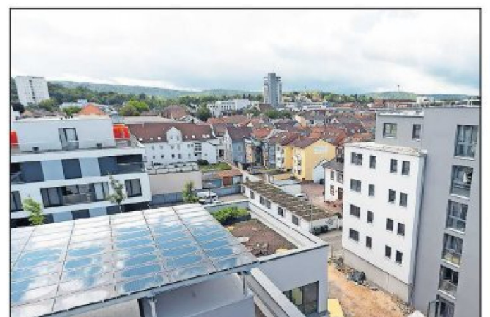
Blick auf den Neubau der PRE-Gruppe in der Weberstraße von einer Dachterrasse aus.
